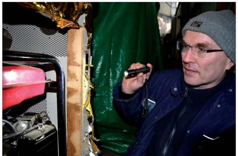
Alles an Bord: Alexander Mai wirft einen Blick auf das Notstromaggregat.
