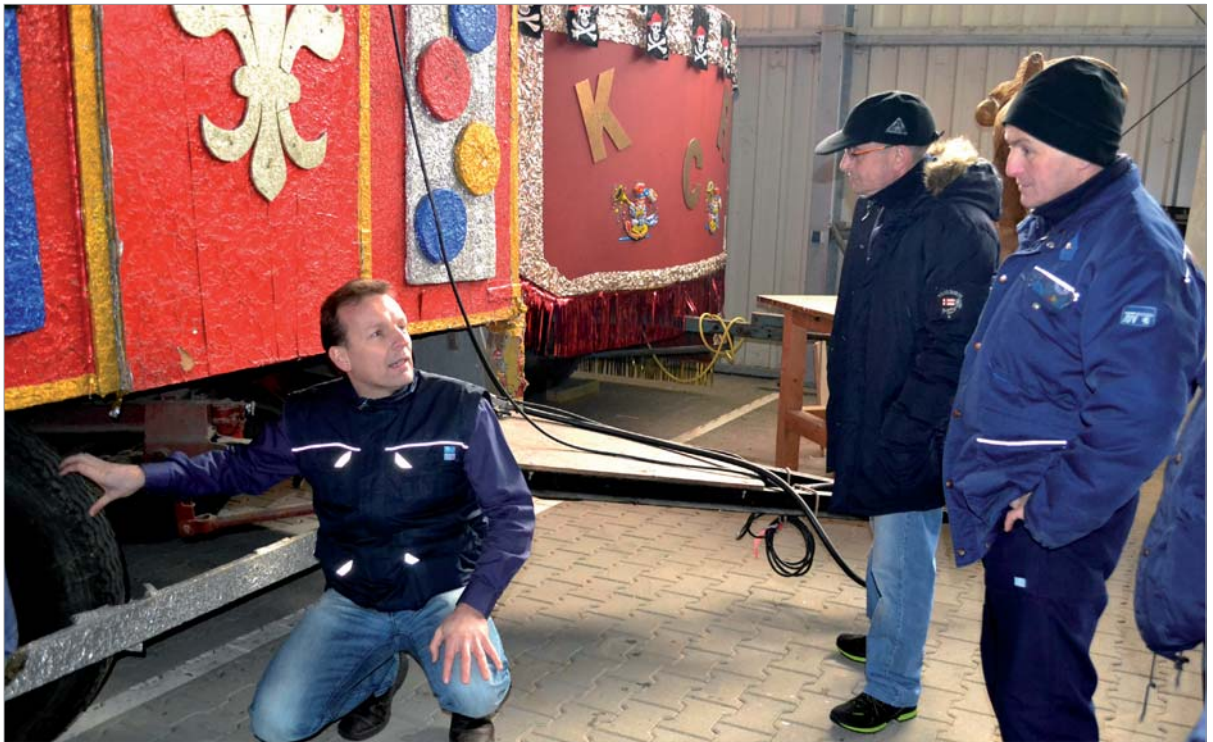
Prüfende Blicke: Holger Werking (kniend) zeigt Kollegen neuralgische Punkte an Umzugswagen auf.
